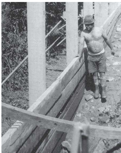
Treballs de fonamentació
