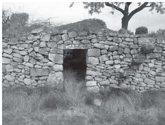
Barraca encastada en un marge de vinya
