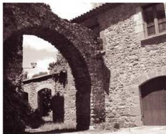
Vista de l'interior del Clos
