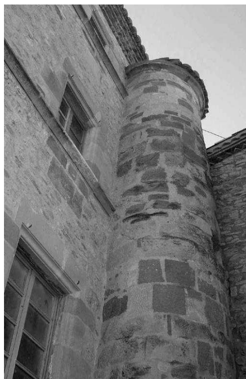
Detall de la façana
