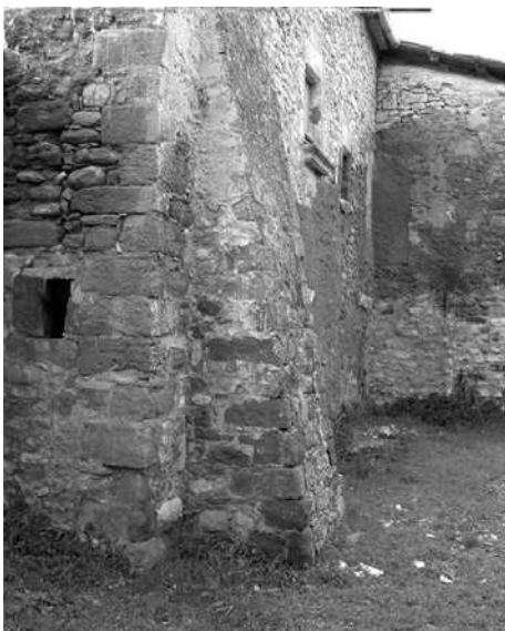
Contrafort a la façana nord de la casa
