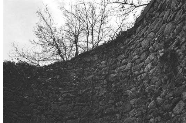
Vista des de l'interior del pou
