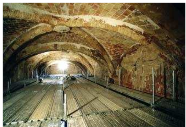
Voltes del temple abans de la restauració
