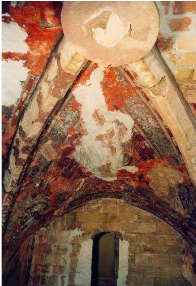
Pany de plementeria de les voltes, amb els estucs de finals del segle XVII, realitzats sobre la pintura ataronjada de 1647
