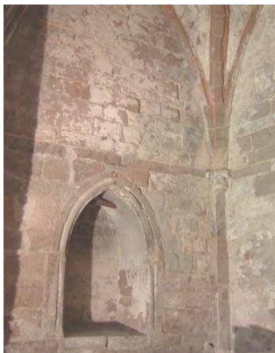
Fornícula oberta al mur oest de la capella gòtica
