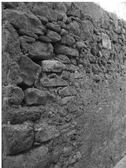
Paret de cal Cisteller
